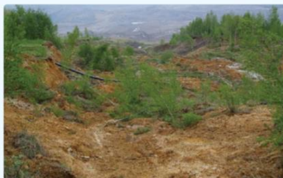
Obr. 10. Mohutné sesuvy pod Jezeřím na Mostecku: pohled shora na začínající zemní proud při západním okraji svahové deformace. Foto P. Kycl.
